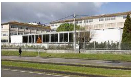
Pabellón IES Rafael Puga. A Coruña.
