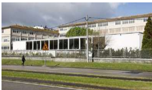
Pabellón IES Rafael Puga. A Coruña.
